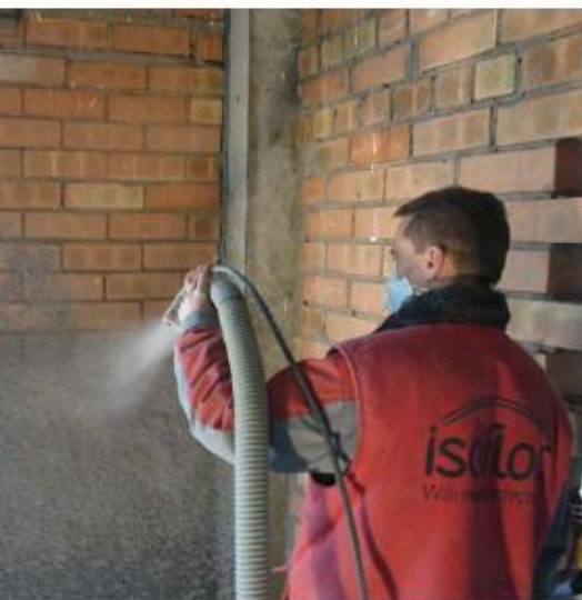
celulosa isofloc proyectada sobre pared y muros
